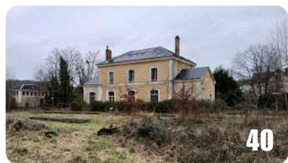
ANCIENNE GARE DE LAVENAY (72) 40
