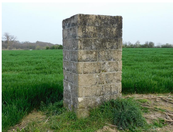
Figure 1. Puits d'aération de la cavité
