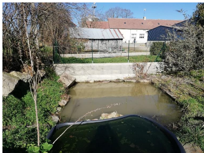
Figure 4: Illustration du mur en parpaing récemment posé © A. Le Coz
