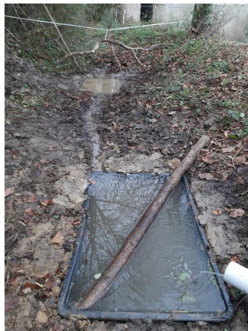
Figure 8 : Vasque artificielle installée à Vernie – E. Lantuejoul
