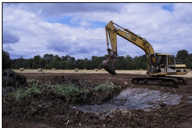
Figure 17 : Etrépage de la parcelle ZR 38
