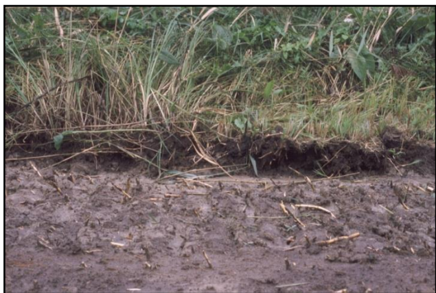
Figure 16 : Roselière en cours d'étrépage
